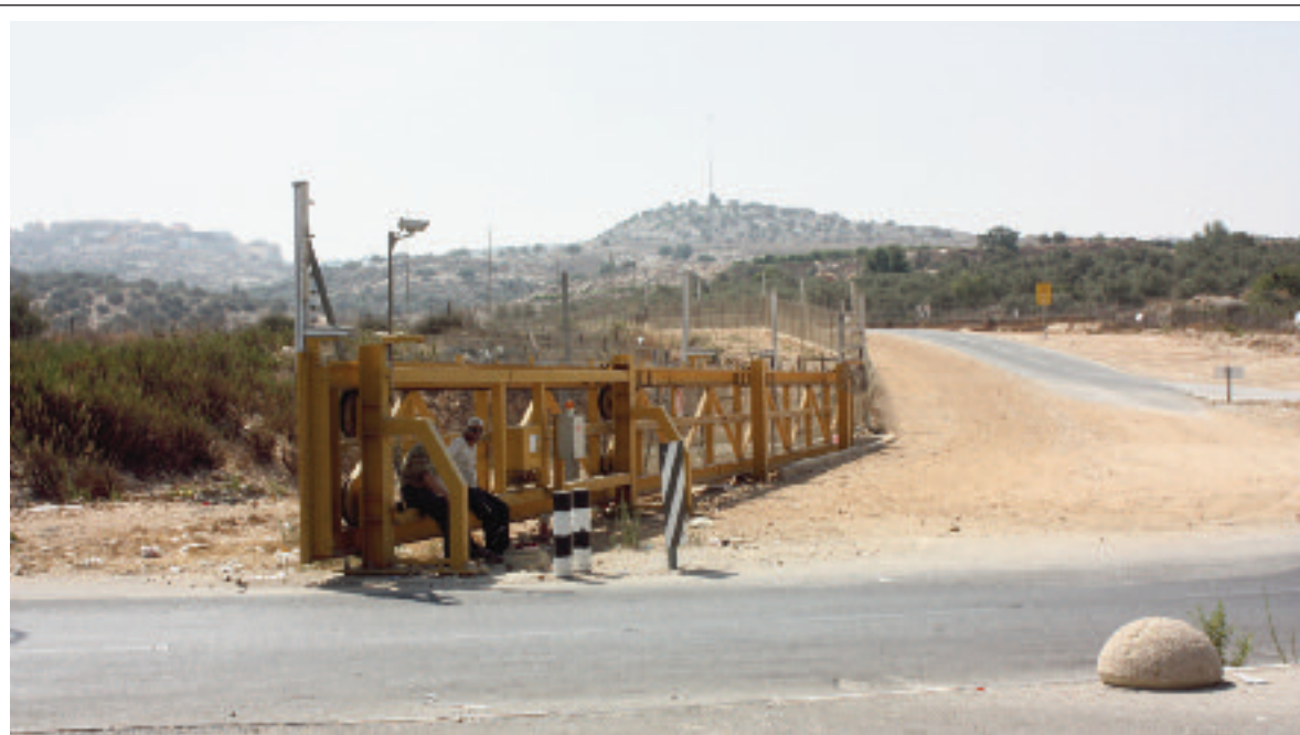
Der Sicherheitszaun ist mit einer ultramodernen und hochsensiblen Überwachungsanlage ausgerüstet, dank der man jedes näher kommende Element erkennen sowie Mensch und Tier voneinander unterscheiden kann.
